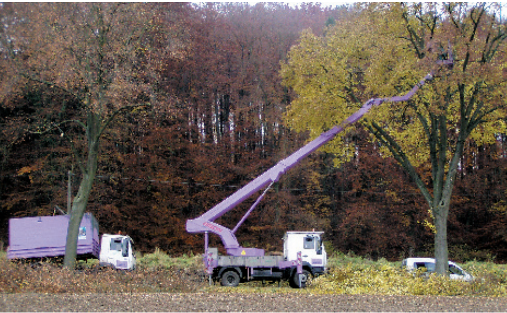
Einsatz des Baumpflegeteams mit Hubsteiger und Holzhackler bei der Herstellung des Lichtraumprofils.
